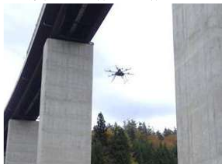
写真-1 UAVによる橋脚の撮影
