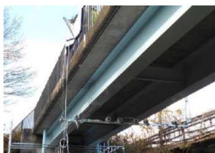
写真-2 簡易装置による桁下の撮影
