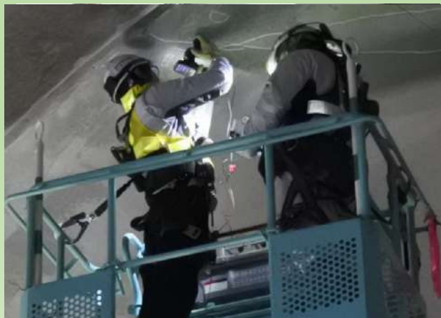
トンネルひび割れ調査例
