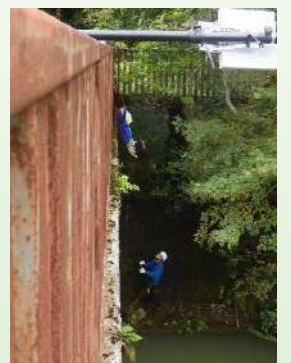
ロープアクセスによる堤体天端から湛水面へのボート搬入状況
