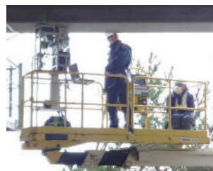
橋梁点検車による計測状況
