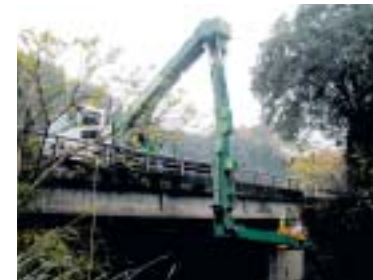
橋梁の点検状況
