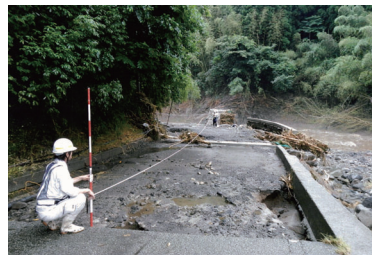
被災調査状況
