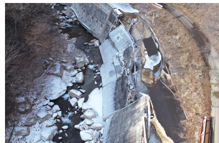
ドローンによる被災状況把握(立ち入り困難箇所)
