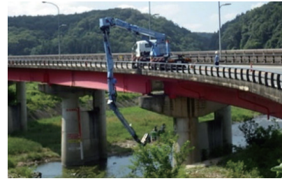
橋梁点検車や高所作業車による点検状況
